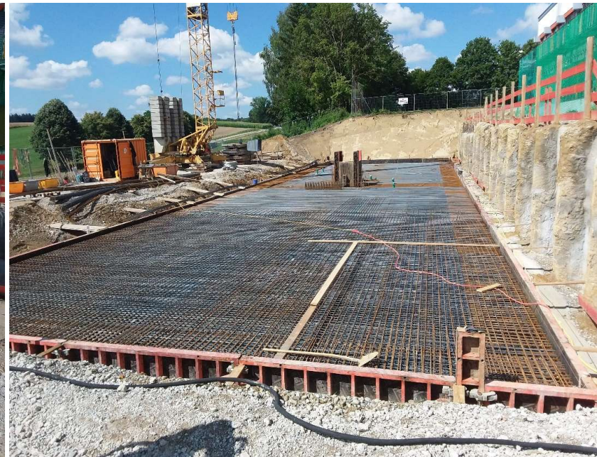
Bewehrung Bodenplatte Erweiterungsbau
