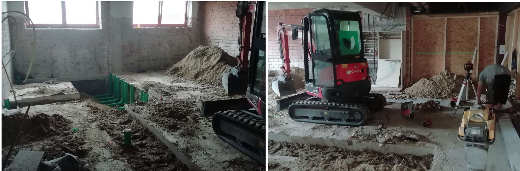
Abbruch des Bestands und Herstellung der neuen Sanitäranlagen
