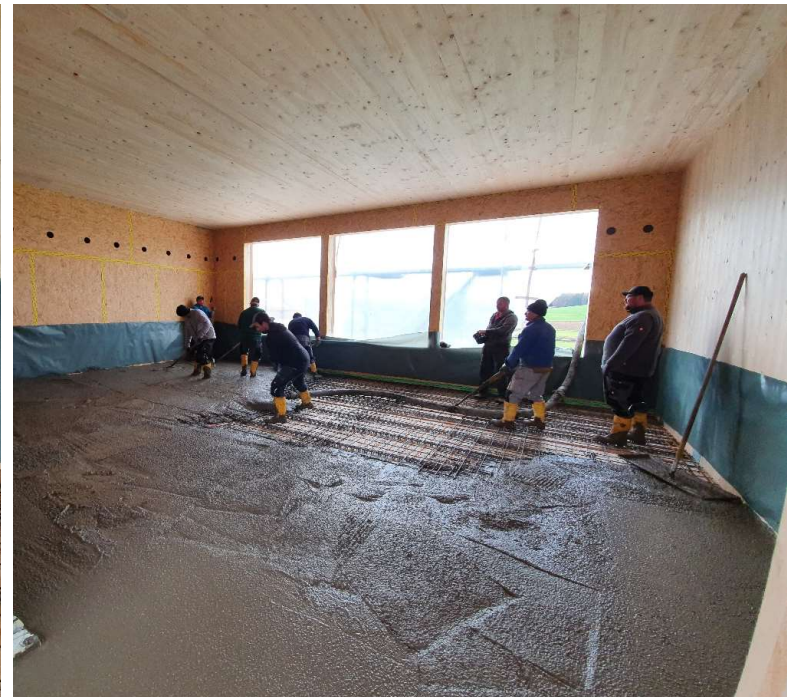
Betonieren der Holzverbunddecke
