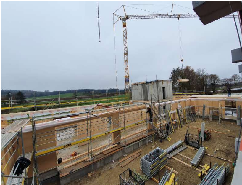
Verlegung der Holzverbunddecke über EG
