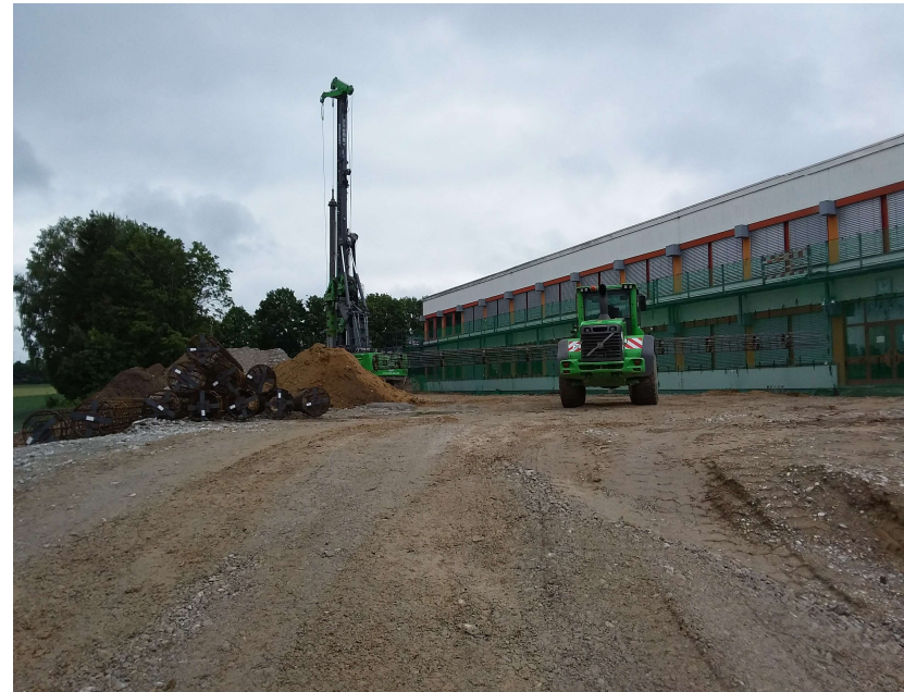
Herstellung Bohrpfahlwand
