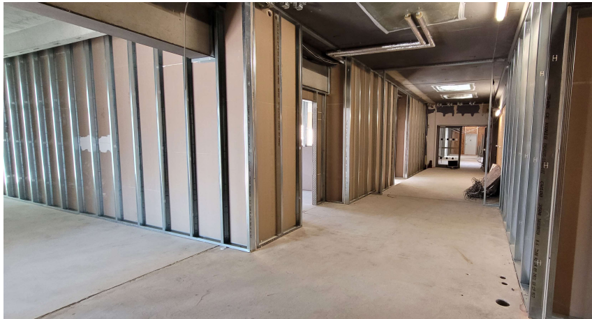
Trockenbau Klassenzimmer
