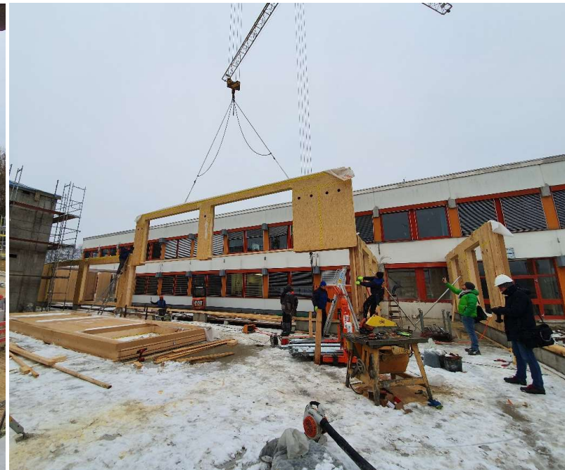
Setzen der Außenwände zum Innenhof
