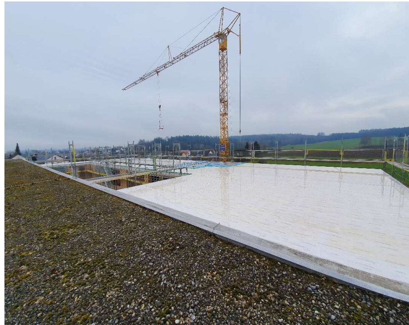
Decke über OG (Winterdicht)
